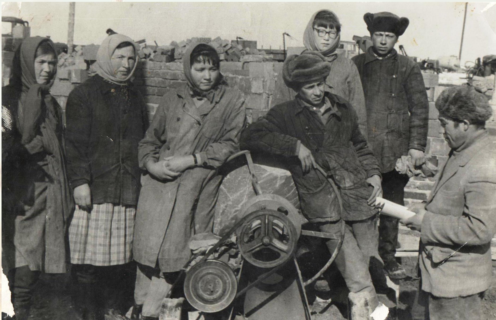
Разнарядка на строительной площадке.
